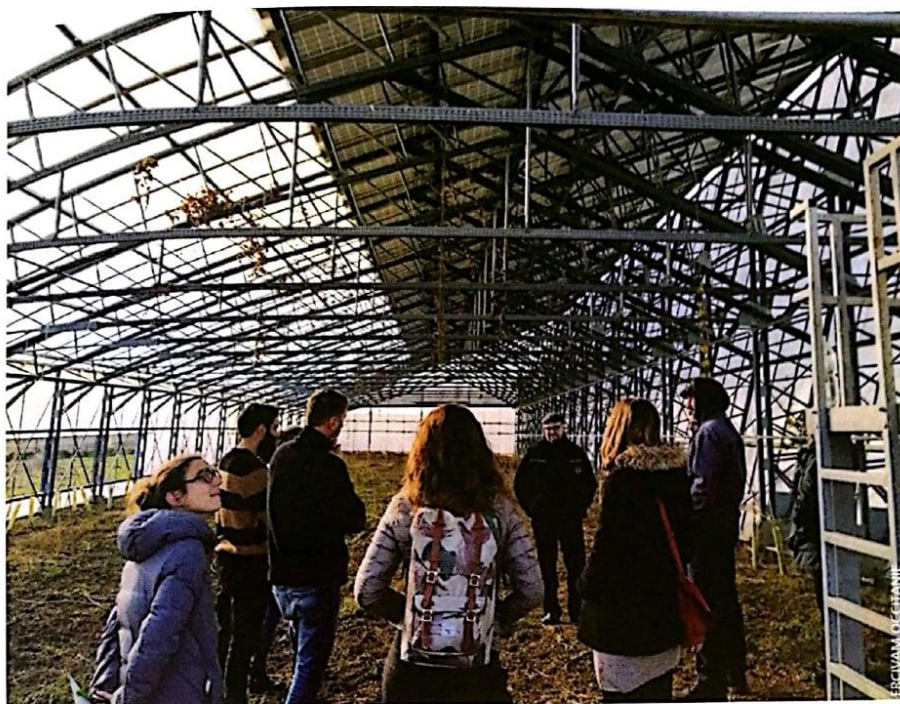
Visite sur le domaine de la Grande Courtade à Béziers (34), qui a mis en place une houblonnière sous serre photovoltaïque.
